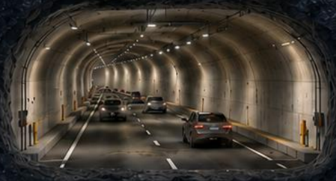
Tie- ja huoltotunnelit
