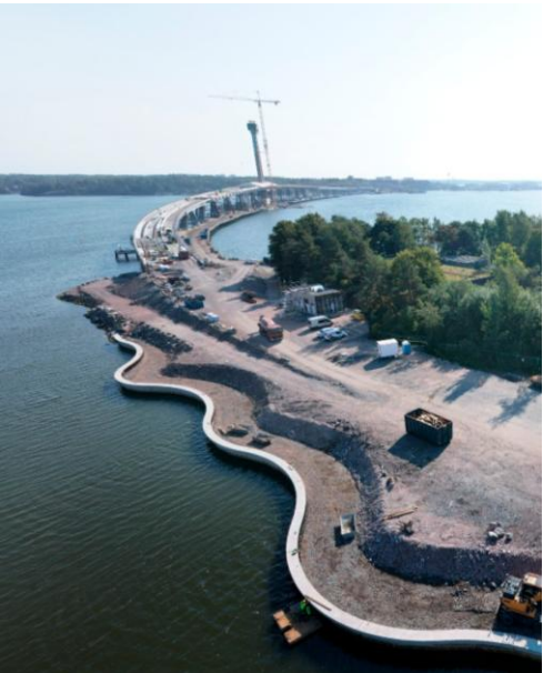
Sillanrakentaminen ja -korjaus
